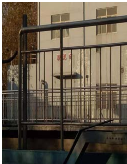
污水处理站脱泥间
