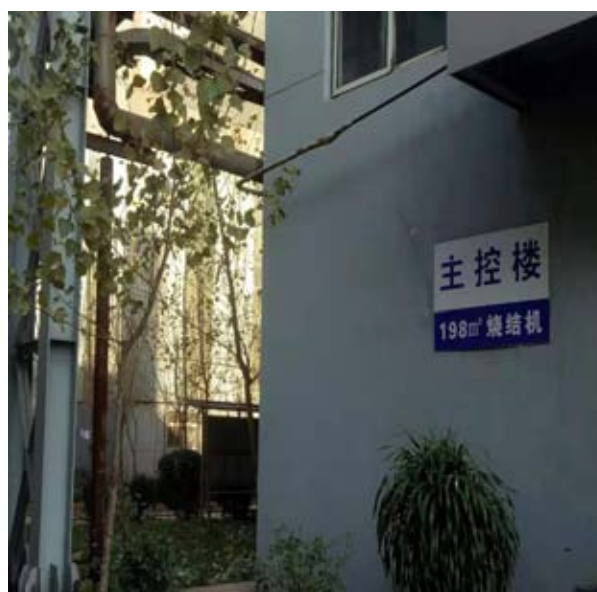
198m 2 烧结机主控
