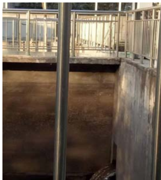
污水处理站污水池
