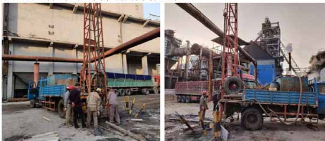
S3-3 (5#高炉冲渣池东侧) 现场采样照片:
