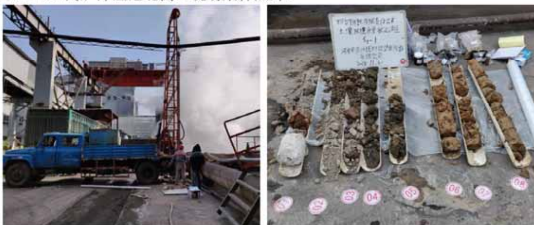
S3-1 (1#高炉冲渣池北侧) 现场采样照片:
