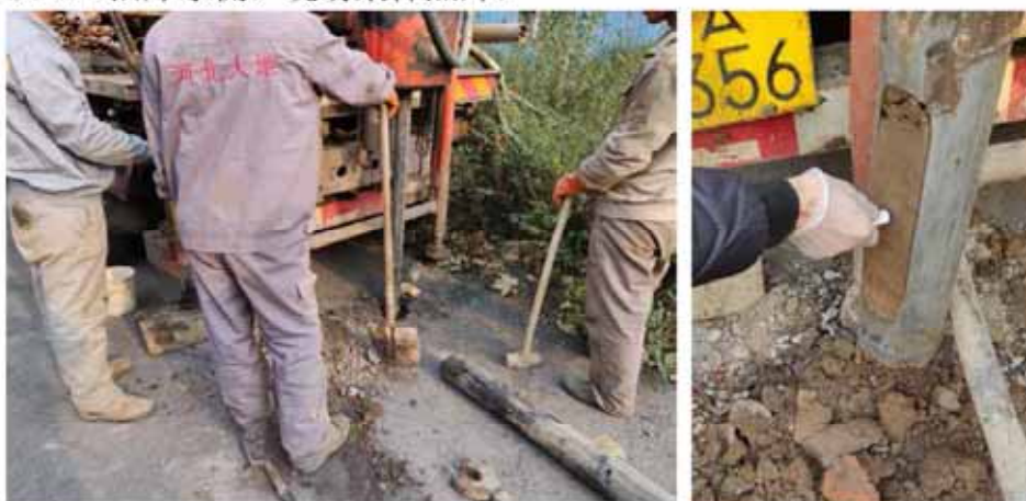
S1-6 (油库东侧) 现场采样照片:
