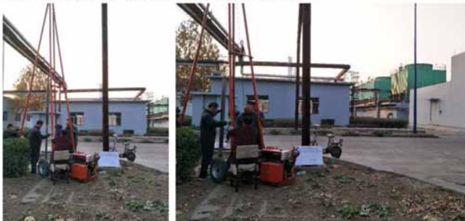
S5-1 (不锈钢生产废水收集池) 现场采样照片:
