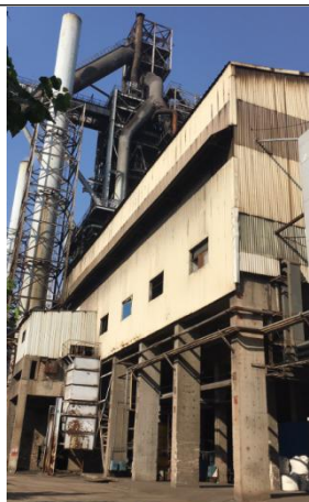
炼铁高炉，地上设施，地面硬化，较干净
