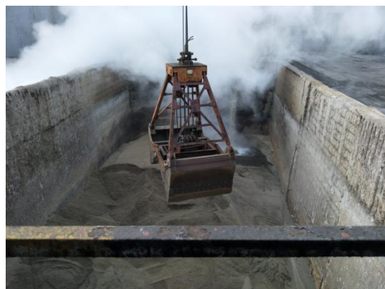
1#高炉冲渣池，地下结构，地面有渣粒
