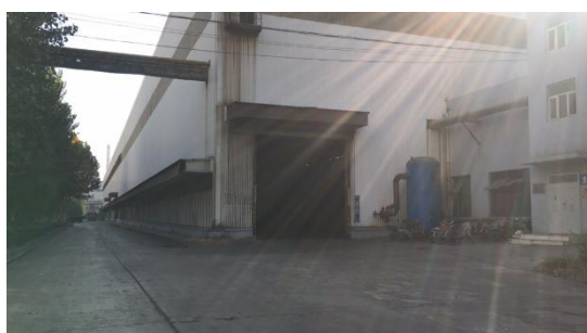
线材车间，密闭构造，地面硬化，较干净
