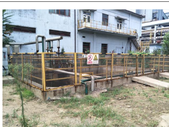
焦化厂区污水收集，池体为地下砖砌体结构
