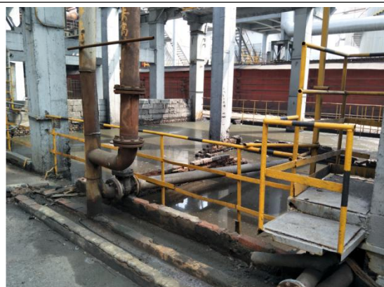
湿熄焦池，砖砌体结构，位于地下
