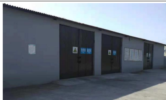
危废库，单独设置，密闭结构，地面标准化建设，未发现物料遗撒痕迹
