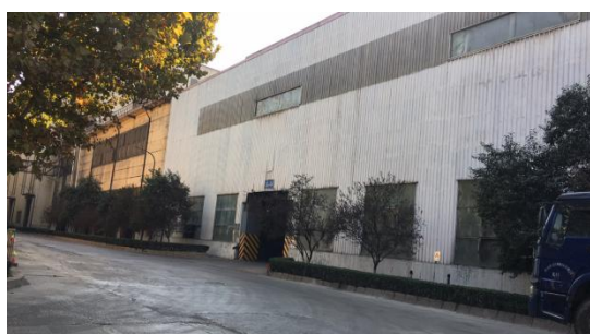
炼钢车间，密闭构造，地面硬化，较干净
