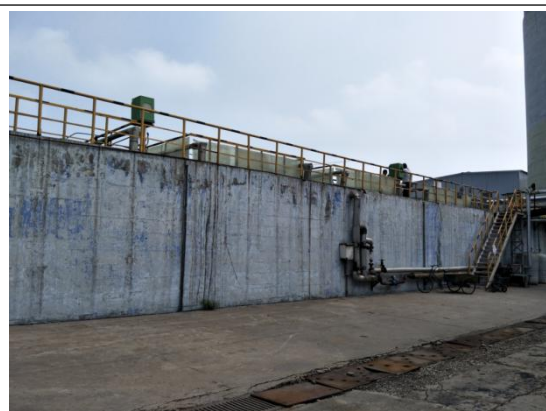
净化车间污水处理站，池体为半地下钢筋混凝土浇筑，周边地面硬化，未发现污染痕迹
