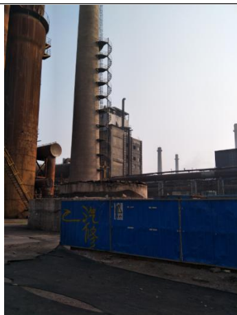
原 4#高炉，现已拆除，地面硬化，较干净
