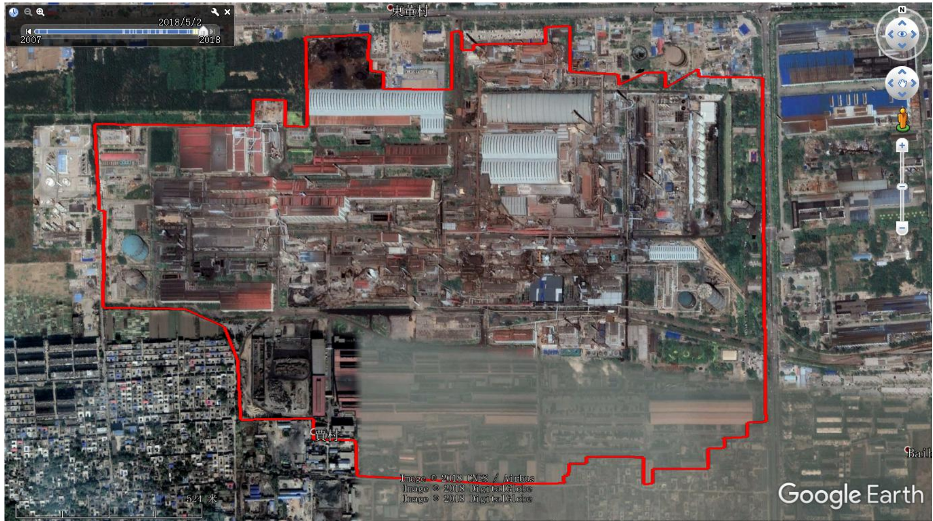
图 2.3-3 邢台钢铁有限责任公司谷歌影像图（2018.5） （线材货场已投入运行，烧结工段车间和料场已完成封闭改造）
