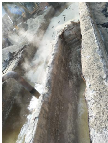
5#高炉冲渣池，地下结构，地面有渣粒
