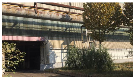
线材车间，密闭构造，地面硬化，较干净
