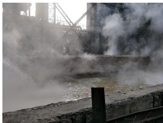
3#高炉冲渣池，地下结构，地面有渣粒
